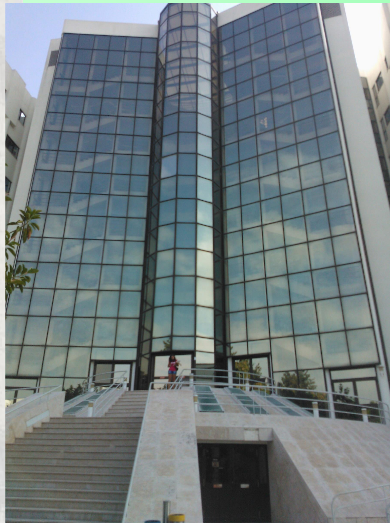
Fig. 1. Edifício central da Faculdade de Ciências Sociais e Humanas da Universidade Nova de Lisboa. O prédio, dividido em duas alas, foi projetado para se assemelhar a um livro aberto. Foto: Mario Francisco Simões Jr.
